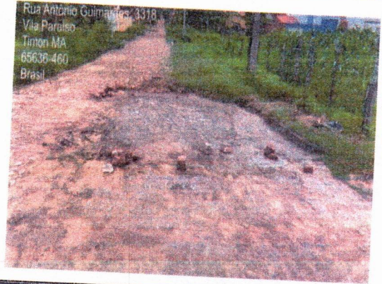
5.3 PAVIMENTAÇÃO EM PARALELEPIPEDO
