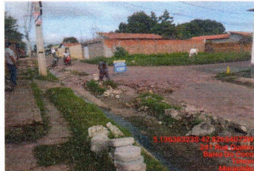
1.5 DEMOLIÇÃO E REMOÇÃO DE PAVIMENTO
