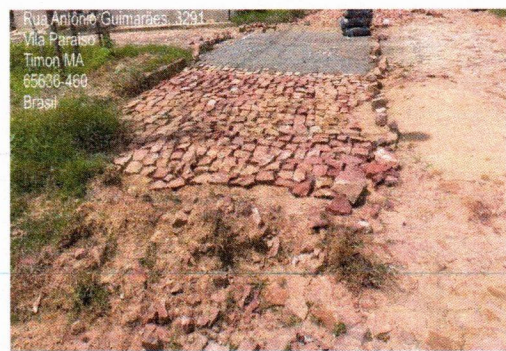
5.3 PAVIMENTAÇÃO EM PARALELEPIPEDO
