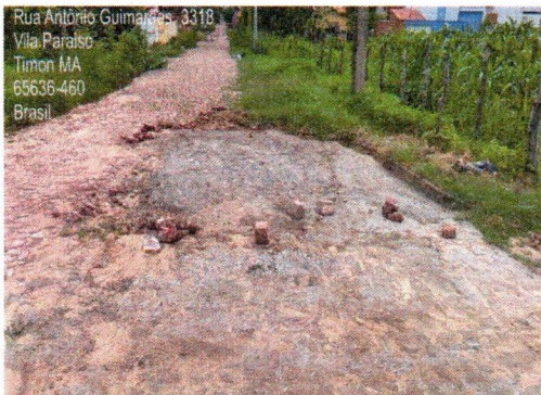
5.3 PAVIMENTAÇÃO EM PARALELEPIPEDO
