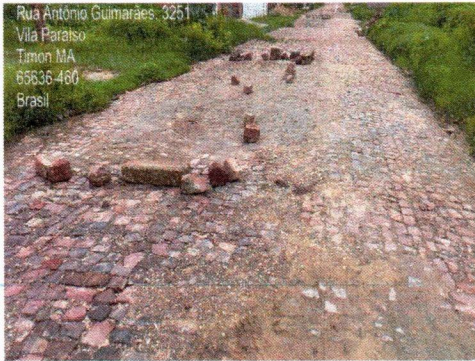
5.3 PAVIMENTAÇÃO EM PARALELEPIPEDO
