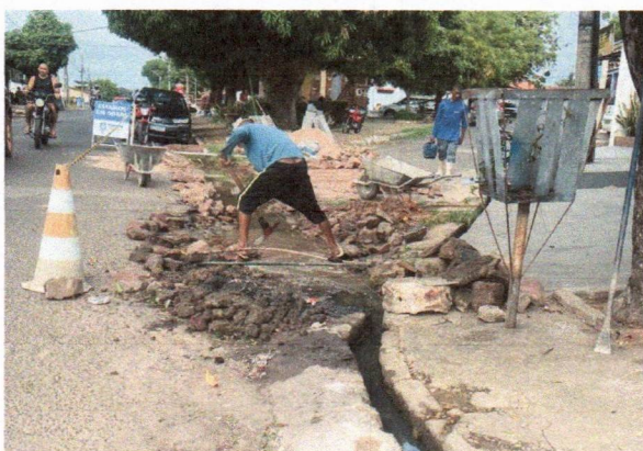
1.2 DEMOLIÇÃO DE PAVIMENTAÇÃO ASFÁLTICA
