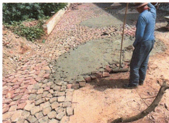
5.3 PAVIMENTAÇÃO EM PARALELEPIPEDO
