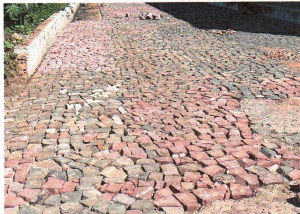
5.3 PAVIMENTAÇÃO EM PARALELEPÍPEDO
