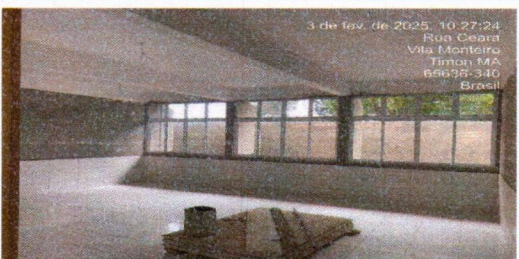
SALA COM ESQUADRIAS, COM CERAMICA, SEM PINTURA, COM FORRO , SEM HIDRAULICA, SEM ELETRICA
