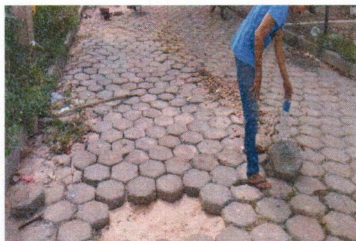
5.3 PAVIMENTAÇÃO EM PARALELEPÍPEDO
