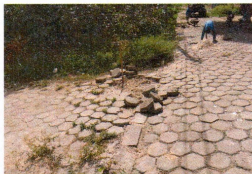
5.3 PAVIMENTAÇÃO EM PARALELEPÍPEDO
