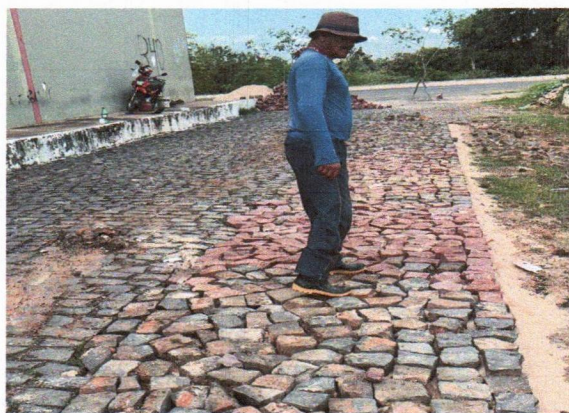
5.3 PAVIMENTAÇÃO EM PARALELEPIPEDO
