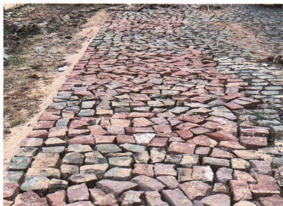
5.3 PAVIMENTAÇÃO EM PARALELEPIPEDO
