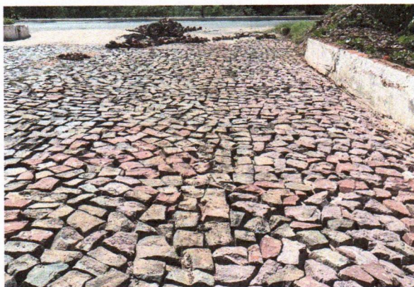
5.3 PAVIMENTAÇÃO EM PARALELEPIPEDO
