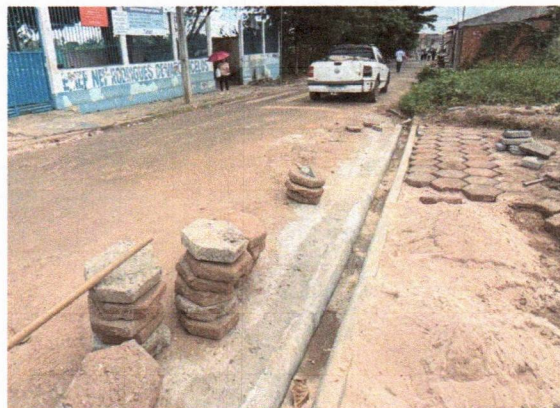
5.3 PAVIMENTAÇÃO EM PARALELEPÍPEDO
