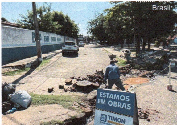
1.2 DEMOLIÇÃO DE PAVIMENTAÇÃO ASFÁLTICA
