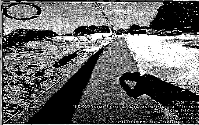
3.10 EXECUÇÃO DE PASSEIO (CALÇADA) - RUA 107 - CIDADE NOVA
