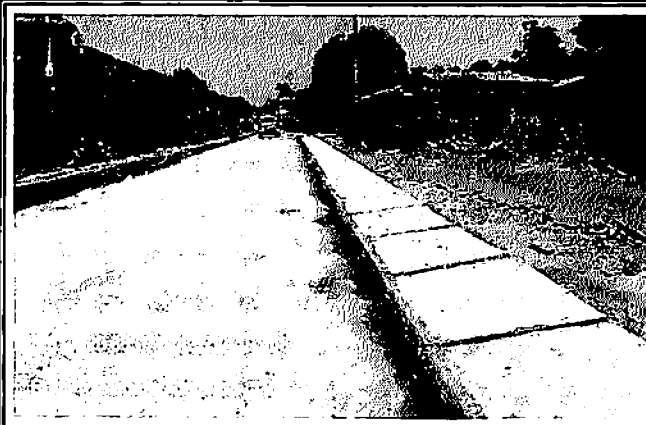
3.10 EXECUÇÃO DE PASSEIO - RUA PROJETADA - CIDADE NOVA 2
