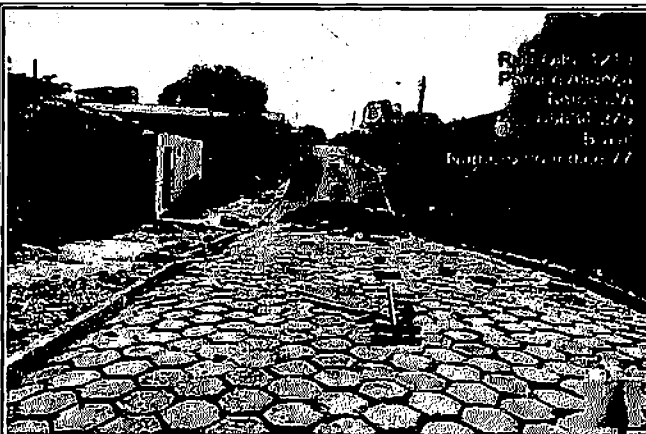
3.2 EXECUÇÃO DE PAVIMENTO EM PISO INTERTRAVADO - RUA 8 - PARQUE ALIANÇA
