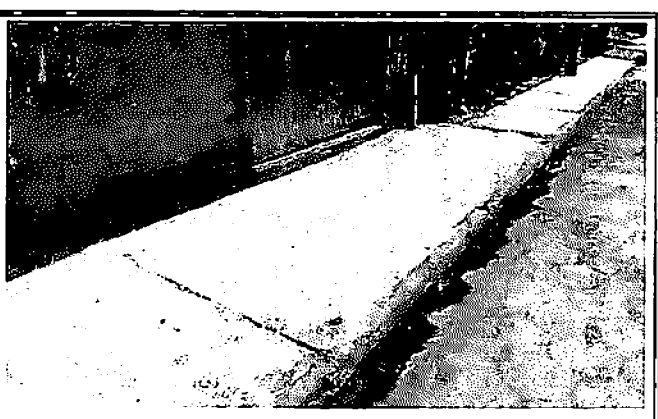
3.10 EXECUÇÃO DE PASSEIO - RUA 30 - CIDADE NOVA 2
