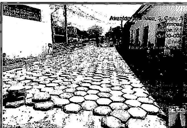
3.2 EXECUÇÃO DE PAVIMENTO EM PISO INTERTRAVIDO - AV FORMOSA
