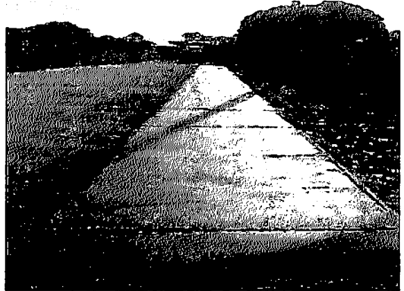
3.10 EXECUÇÃO DE PASSEIO (CALÇADA)
