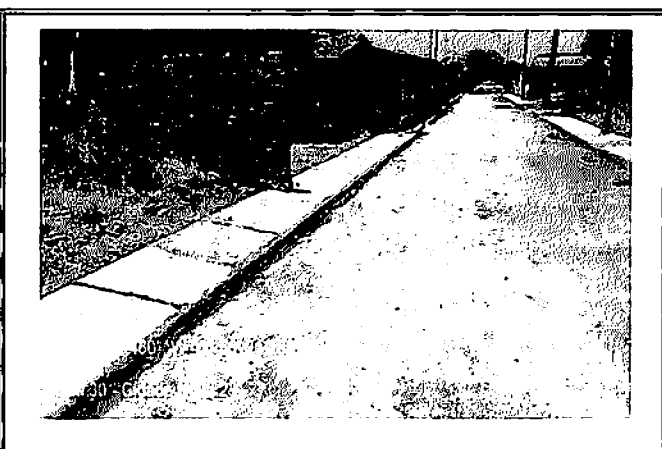
3.10 EXECUÇÃO DE PASSEIO - RUA 30 - CIDADE NOVA 2
