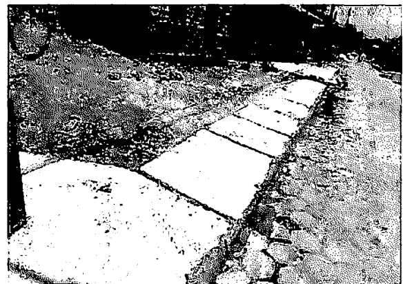
3.10 EXECUÇÃO DE PASSEIO (CALÇADA)
