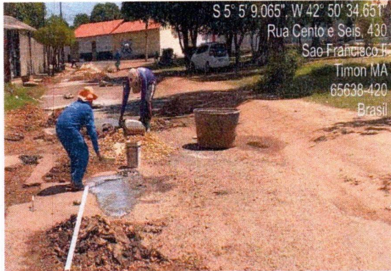
2.3 ATERRO C/ COMPACTAÇÃO
