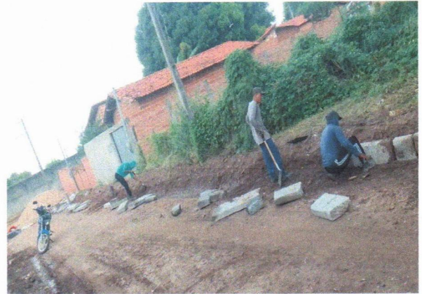
8.2 GUIA (MEIO-FIO) CONCRETO
