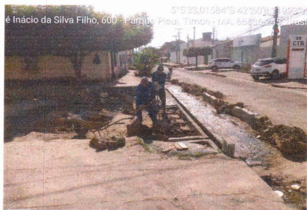
1.3 DEMOLIÇÃO DE CONCRETO
