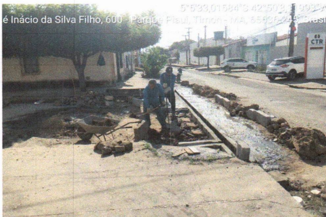
1.3 DEMOLIÇÃO DE CONCRETO
