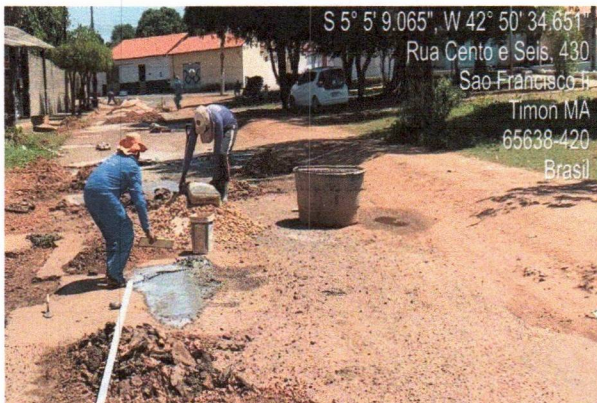
2.3 ATERRO C/ COMPACTAÇÃO
