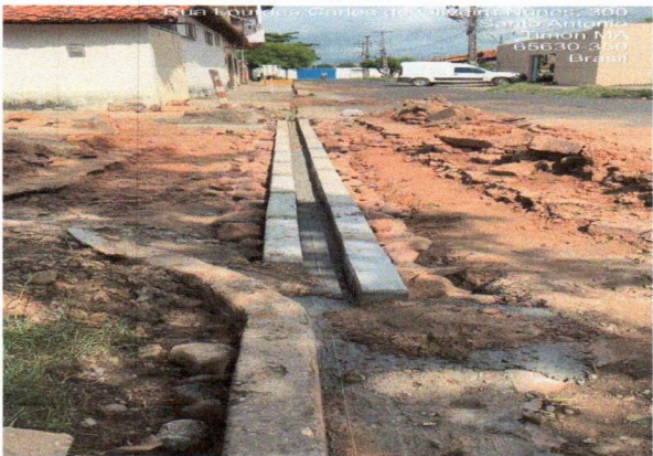
8.2 GUIA (MEIO-FIO) CONCRETO
