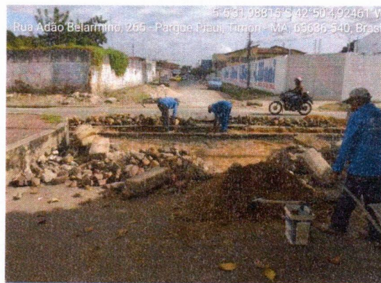
2.2 ESCAVAÇÃO MANUAL DE VALA
