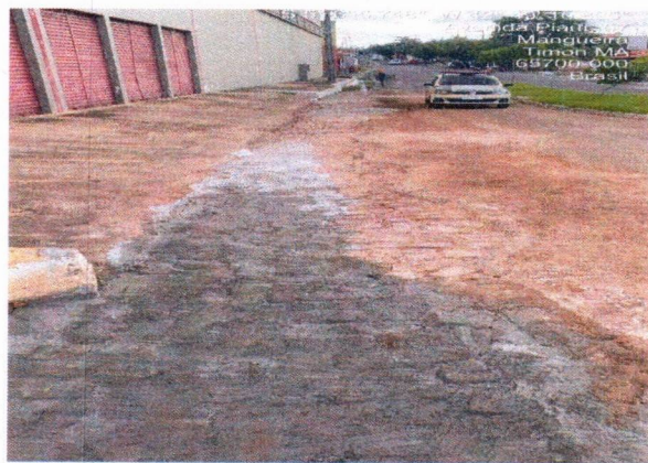
5.3 PAVIMENTAÇÃO EM PARALELEPIPEDO
