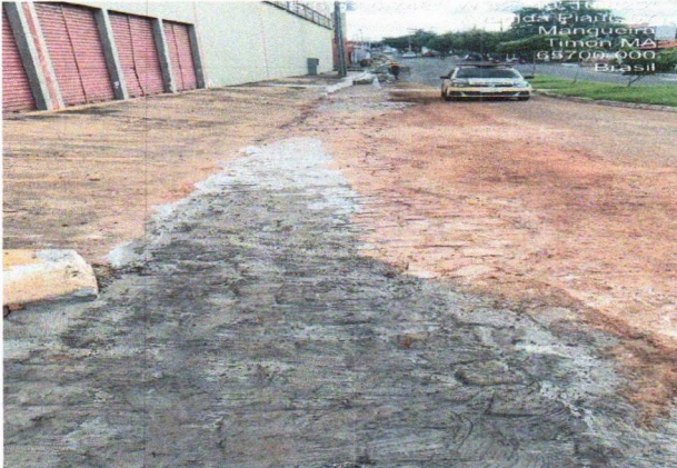
5.3 PAVIMENTAÇÃO EM PARALELEPIPEDO
