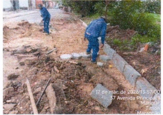
5.3 PAVIMENTAÇÃO EM PARALELEPIPEDO
