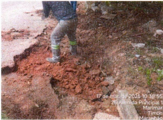
8.5 REMOÇÃO MANUAL DE PAVIMENTO
