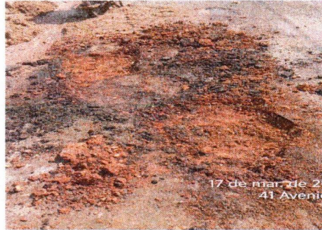
8.5 REMOÇÃO MANUAL DE PAVIMENTO
