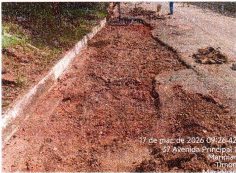
8.5 REMOÇÃO MANUAL DE PAVIMENTO
