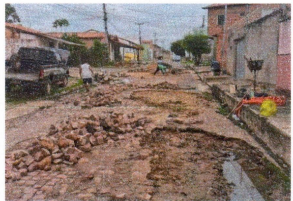
5.3 PAVIMENTAÇÃO EM PARALELEPIPEDO
