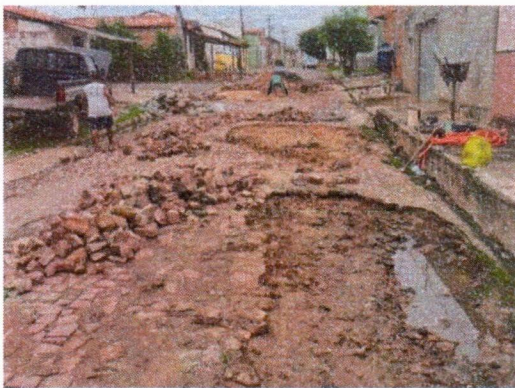
5.3 PAVIMENTAÇÃO EM PARALELEPIPEDO
