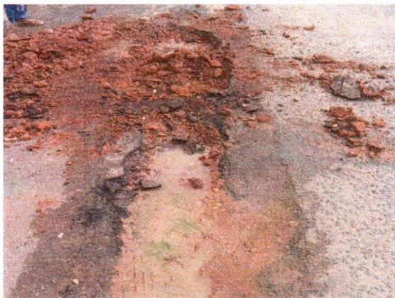
8.5 REMOÇÃO MANUAL DE PAVIMENTO
