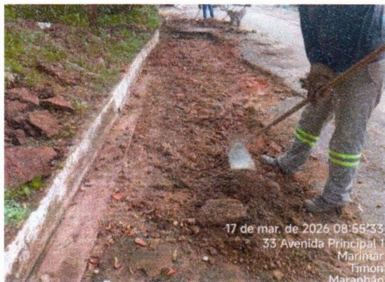
8.5 REMOÇÃO MANUAL DE PAVIMENTO
