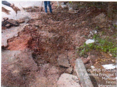
8.5 REMOÇÃO MANUAL DE PAVIMENTO
