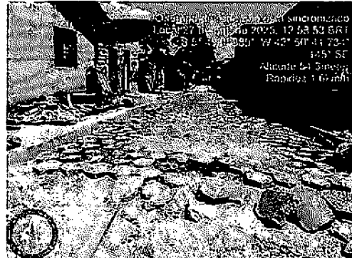
3.8 EXECUÇÃO DE PAVIMENTO EM PISO INTERTRAVADO - S/N. BAIRRO BREJO
