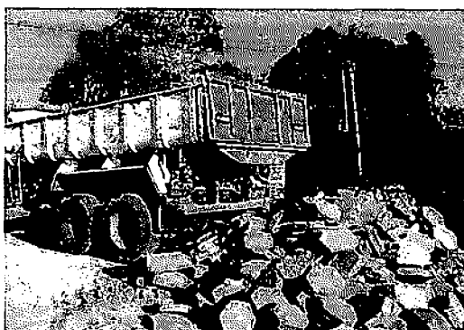
2.6 transporte de material - TRANSPORTE COM CAMINHÃO BASCULANTE - VILA UNIÃO, BAIRRO JULIA ALMEIDA
