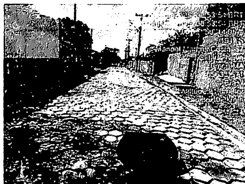
3.8 EXECUÇÃO DE PAVIMENTO EM PISO INTERTRAVADO - RUA 27. BAIRRO CIDADE NOVA
