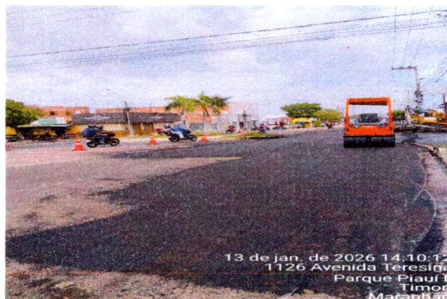
4.3 EXECUÇÃO DE IMPRIMIÇÃO
