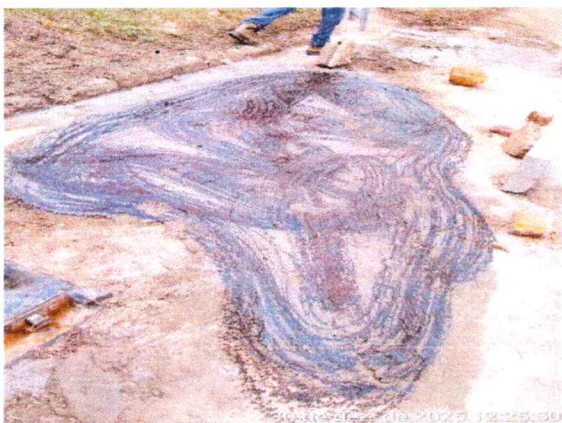
8.1 EXECUÇÃO DE TAPA BURACO
