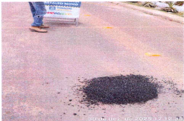
8.1 EXECUÇÃO DE TAPA BURACO
