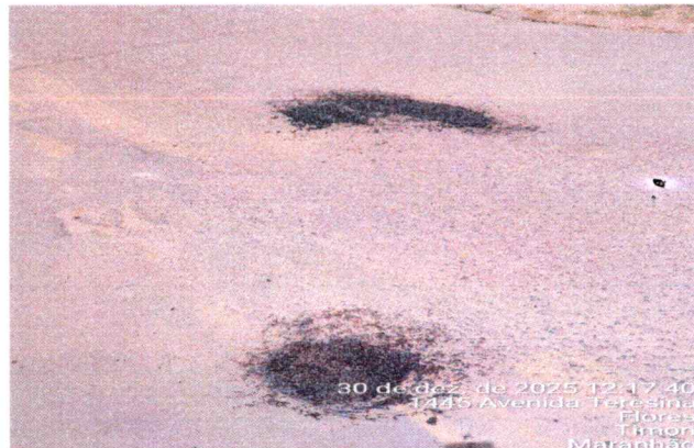
8.1 EXECUÇÃO DE TAPA BURACO
