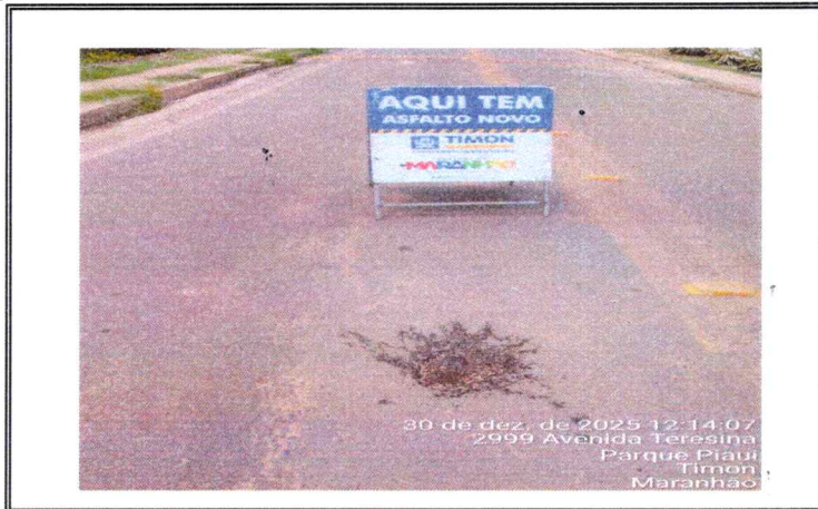
8.3 EXECUÇÃO DE IMPRIMAÇÃO
