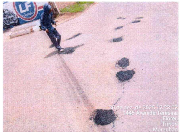
8.1 EXECUÇÃO DE TAPA BURACO
