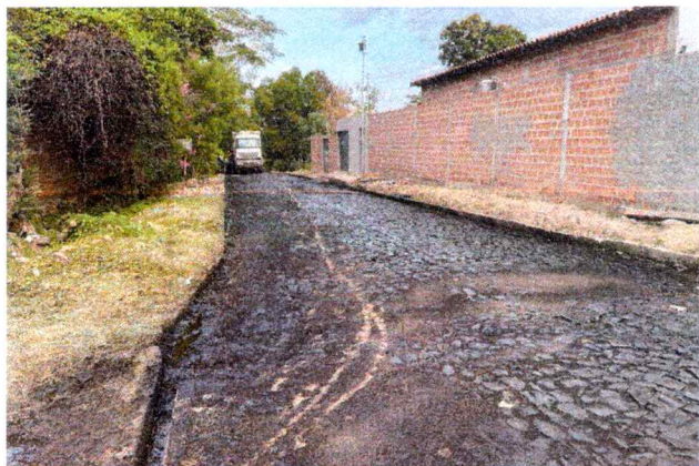
4.3 EXECUÇÃO DE IMPRIMIÇÃO E 4.4 TRANSPORTE COM CAMINHÃO
