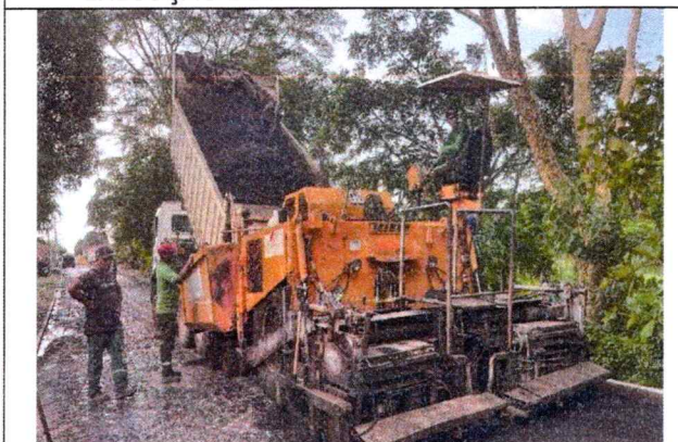
EXECUÇÃO DE RECAPEAMENTO ASFALTICO
