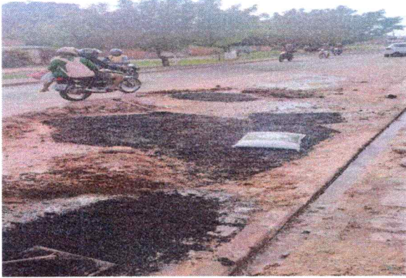
8.1 EXECUÇÃO DE TAPA BURACO
