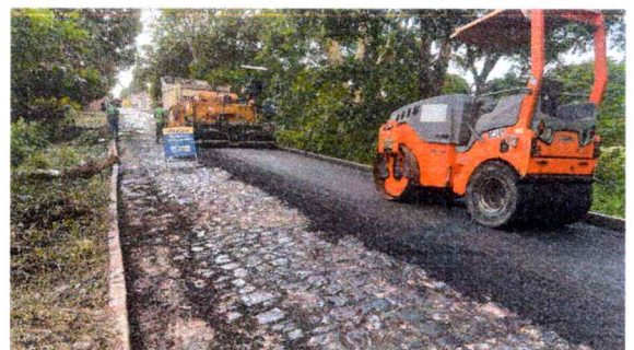
8.1 EXECUÇÃO DE TAPA BURACO
