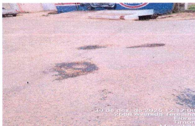
8.1 EXECUÇÃO DE TAPA BURACO
