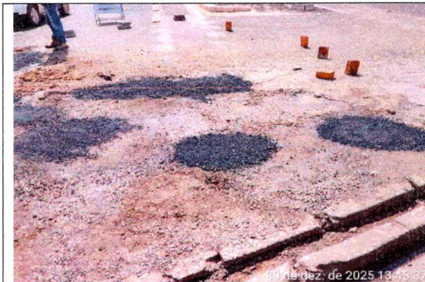
EXECUÇÃO DE TAPA BURACO
