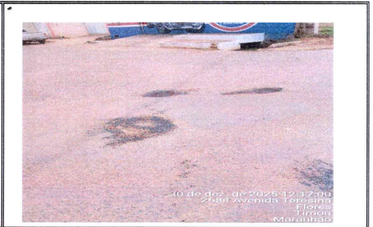
8.3 EXECUÇÃO DE IMPRIMAÇÃO
