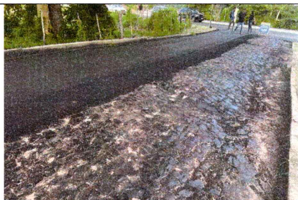
EXECUÇÃO DE RECAPEAMENTO ASFALTICO
