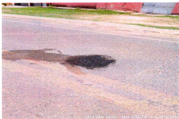
8.1 EXECUÇÃO DE TAPA BURACO
