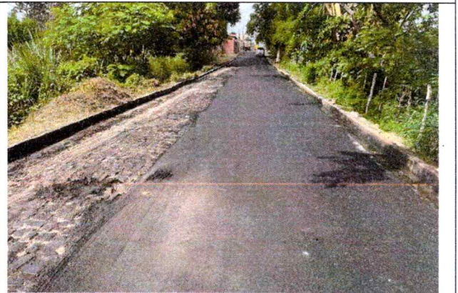
EXECUÇÃO DE RECAPEAMENTO ASFALTICO
