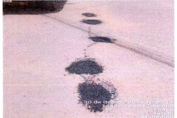
8.1 EXECUÇÃO DE TAPA BURACO
