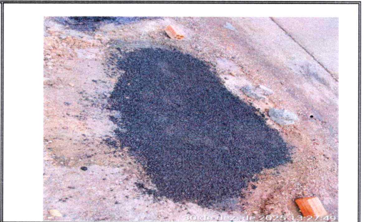
8.1 EXECUÇÃO DE TAPA BURACO
