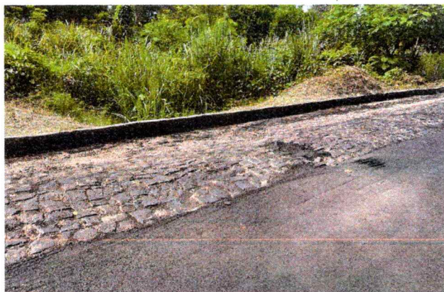
4.3 EXECUÇÃO DE IMPRIMICÃO
