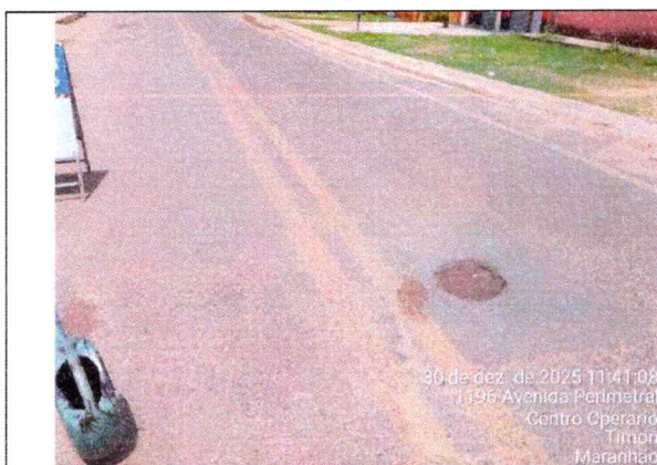
EXECUÇÃO DE TAPA BURACO
