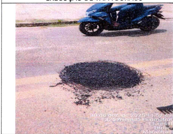
EXECUÇÃO DE TAPA BURACO
