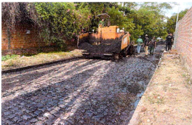
4.3 EXECUÇÃO DE IMPRIMIÇÃO
