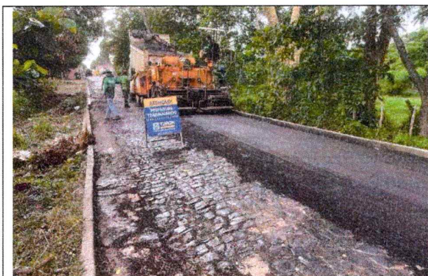
EXECUÇÃO DE RECAPEAMENTO ASFALTICO
