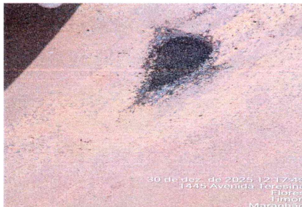
8.1 EXECUÇÃO DE TAPA BURACO
