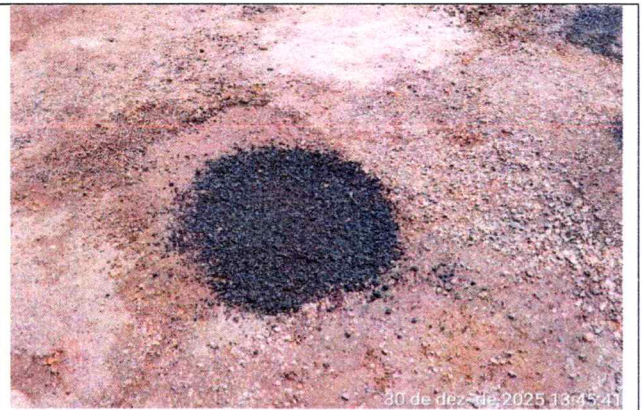
EXECUÇÃO DE TAPA BURACO
