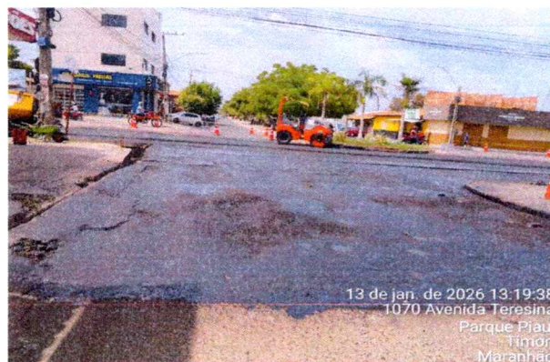
4.3 EXECUÇÃO DE IMPRIMIÇÃO
