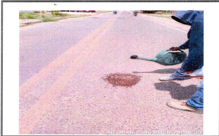
8.3 EXECUÇÃO DE IMPRIMAÇÃO
