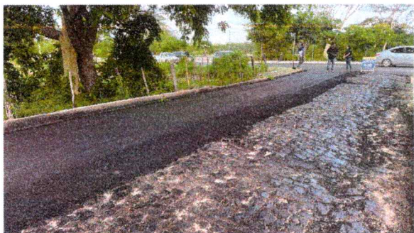
8.1 EXECUÇÃO DE TAPA BURACO
