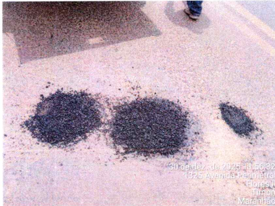
8.1 EXECUÇÃO DE TAPA BURACO
