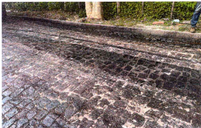
4.3 EXECUÇÃO DE IMPRIMIÇÃO
