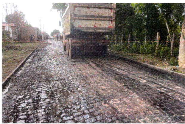
4.3 EXECUÇÃO DE IMPRIMIÇÃO E 4.4 TRANSPORTE COM CAMINHÃO
