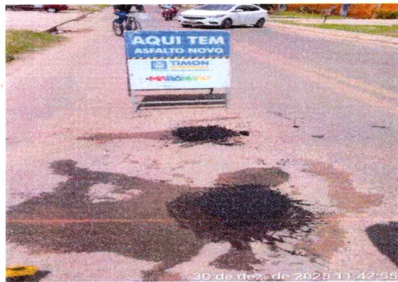
8.1 EXECUÇÃO DE TAPA BURACO
