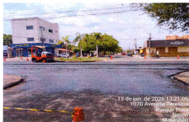
4.3 EXECUÇÃO DE IMPRIMIÇÃO
