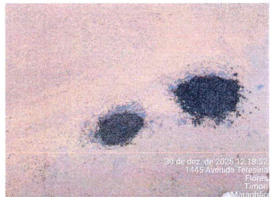
8.1 EXECUÇÃO DE TAPA BURACO
