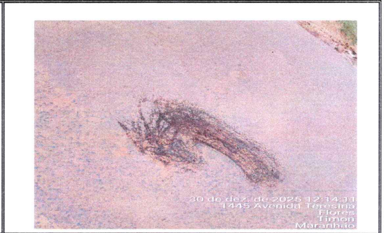
8.3 EXECUÇÃO DE IMPRIMAÇÃO
