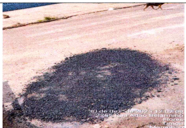
EXECUÇÃO DE TAPA BURACO
