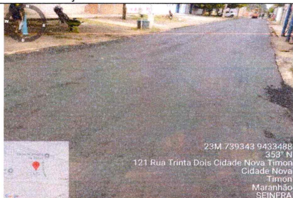
EXECUÇÃO DE RECAPEAMENTO ASFALTICO
