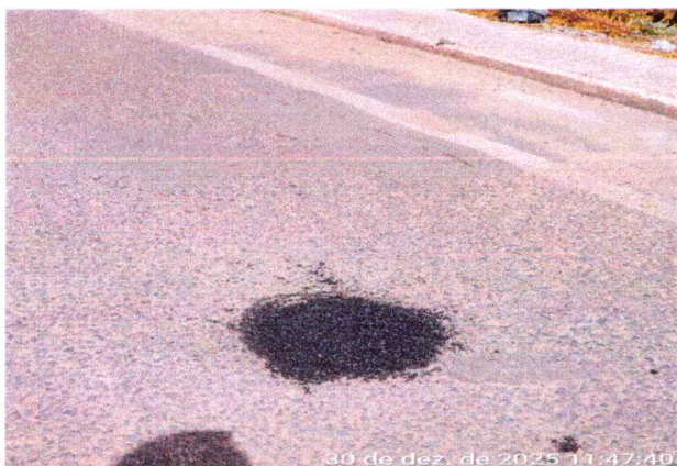
8.1 EXECUÇÃO DE TAPA BURACO
