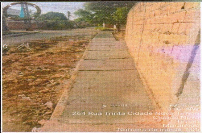
3.10 EXECUÇÃO DE PASSEIO (CALÇADA) - RUA 30 - CIDADE NOVA
