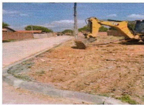
3.6 EXECUÇÃO DE SARJETA DE CONCRETO USINADO
