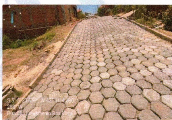
3.2 EXECUÇÃO DE PAVIMENTO EM PISO INTERTRAVADO
