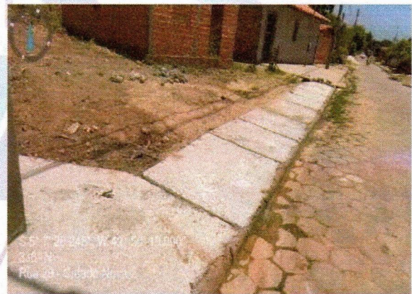
3.10 EXECUÇÃO DE PASSEIO (CALÇADA)
