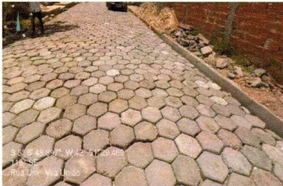
3.2 EXECUÇÃO DE PAVIMENTO EM PISO INTERTRAVADO
