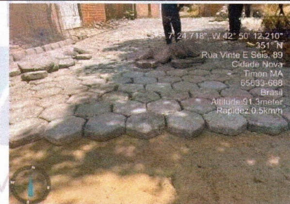
3.2 EXECUÇÃO DE PAVIMENTO EM PISO INTERTRAVADO
