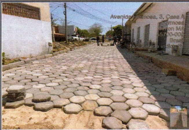
3.2 EXECUÇÃO DE PAVIMENTO EM PISO INTERTRAVADO - AV FORMOSA
