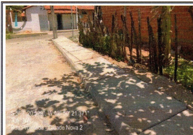
3.10 EXECUÇÃO DE PASSEIO - RUA PROJETADA - CIDADE NOVA 2
