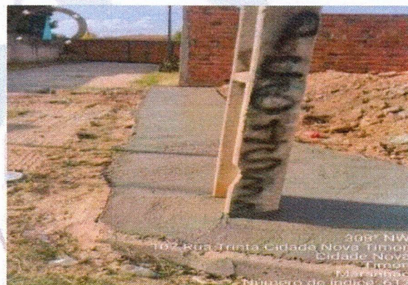
3.10 EXECUÇÃO DE PASSEIO (CALÇADA)
