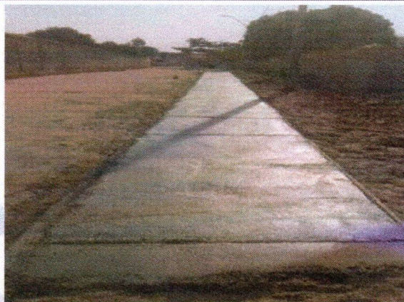
3.10 EXECUÇÃO DE PASSEIO (CALÇADA)
