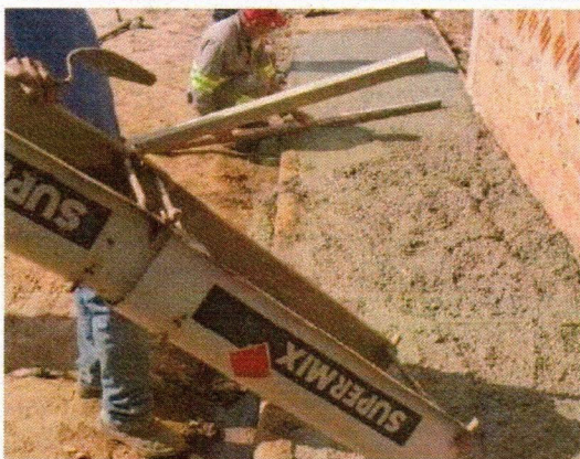
3.10 EXECUÇÃO DE PASSEIO (CALÇADA)
