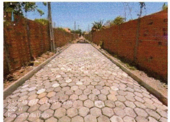
3.2 EXECUÇÃO DE PAVIMENTO EM PISO INTERTRAVADO
