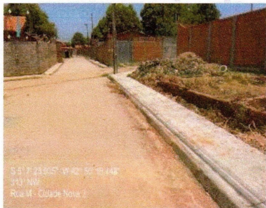
3.10 EXECUÇÃO DE PASSEIO (CALÇADA)
