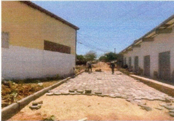
3.2 EXECUÇÃO DE PAVIMENTO EM PISO INTERTRAVADO
