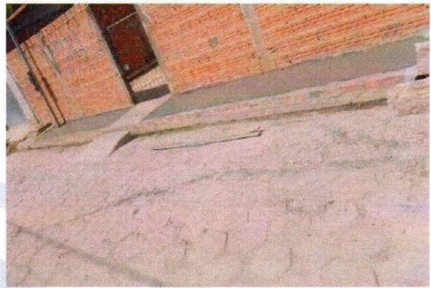
3.10 EXECUÇÃO DE PASSEIO (CALÇADA)
