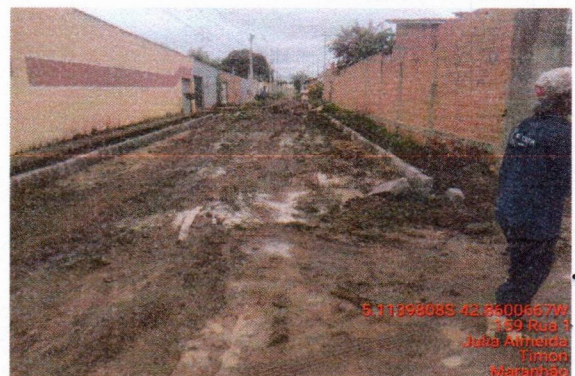
8.2 GUIA (MEIO-FIO) CONCRETO
