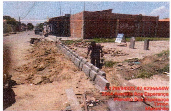
8.3 EXECUÇÃO DE SARJETA
