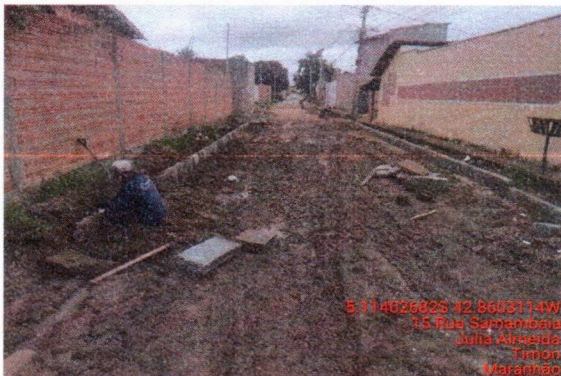
8.2 GUIA (MEIO-FIO) CONCRETO
