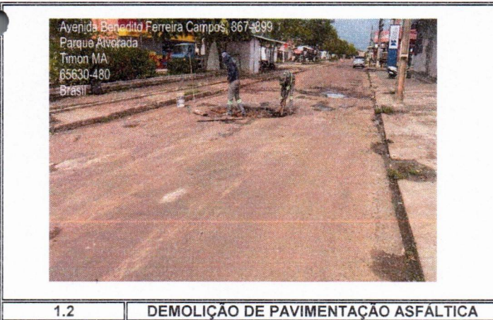
1.2 DEMOLIÇÃO DE PAVIMENTAÇÃO ASFÁLTICA
