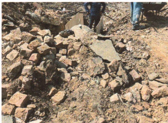
1.5 Demolição e remoção de pavimento
