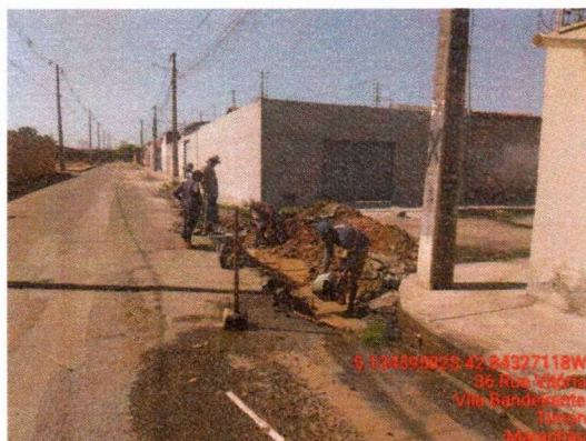
1.4 Retirada de meio fio
