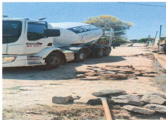
1.5 Demolição e remoção de pavimento em paralelepípedo e poliédrico
