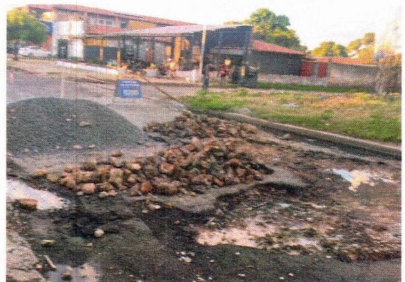
11.2 DEMOLIÇÃO DE PAVIMENTAÇÃO ASFÁLTICA
