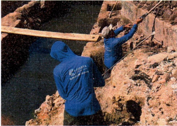
2.2 ESCAVACAO MANUAL DE VALA
