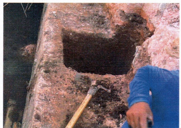
2.2 ESCAVAÇÃO MANUAL DE VALA
