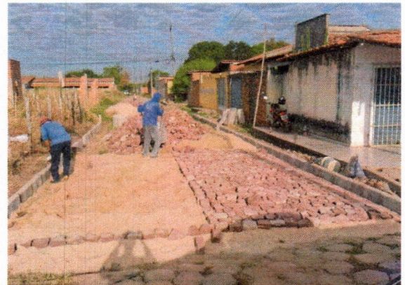
5.3 PAVIMENTAÇÃO EM PARALELEPÍPEDO
