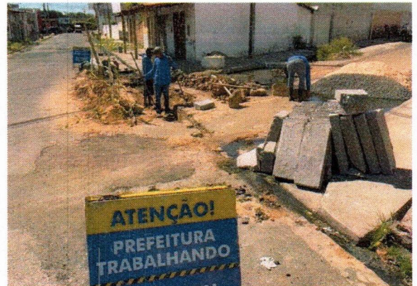
1.4 RETIRADA DE MEIO FIO
