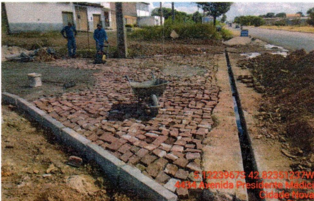
5.3 PAVIMENTAÇÃO EM PARALELEPÍPEDO C/ REJUNTAMENTO
