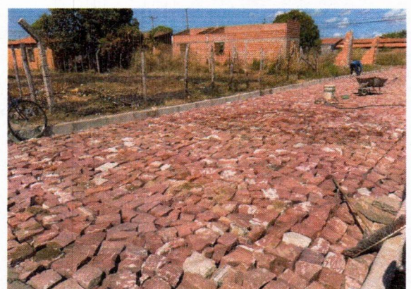
5.3 PAVIMENTAÇÃO EM PARALELEPÍPEDO
