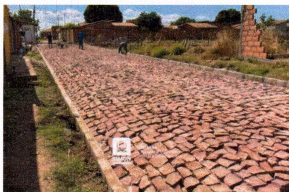
5.3 PAVIMENTAÇÃO EM PARALELEPÍPEDO
