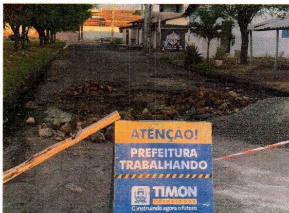
1.2 DEMOLIÇÃO DE PAVIMENTAÇÃO ASFÁLTICA
