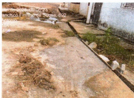
8.3 EXECUÇÃO DE SARJETA
