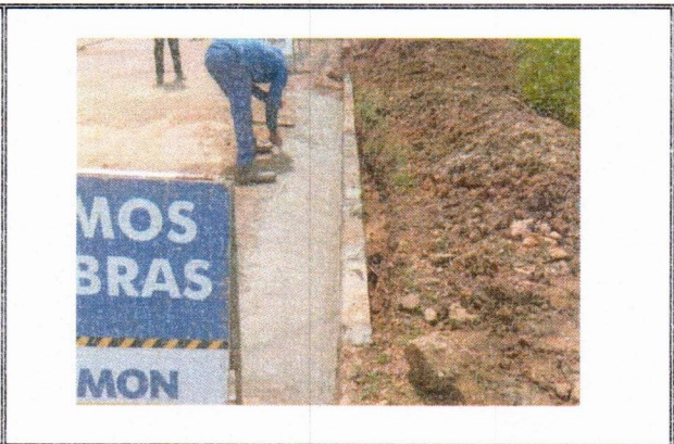
8.3 EXECUÇÃO DE SARJETA
