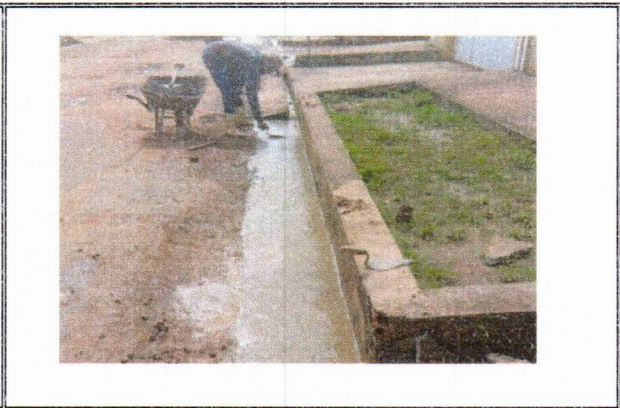
8.3 EXECUÇÃO DE SARJETA
