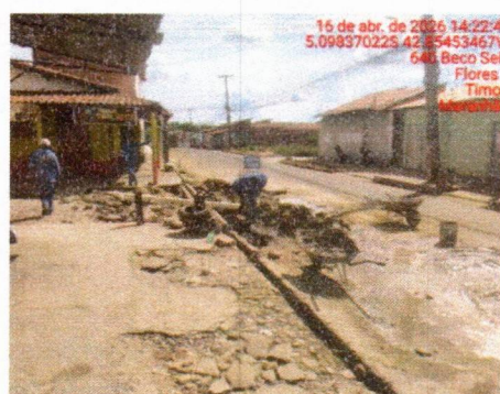
8.3 EXECUÇÃO DE SARJETA
