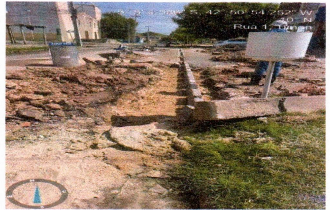
1.2 Demolição de pavimentação asfáltica
