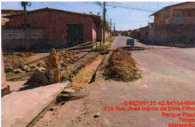
2.2 Escavação manual de vala
