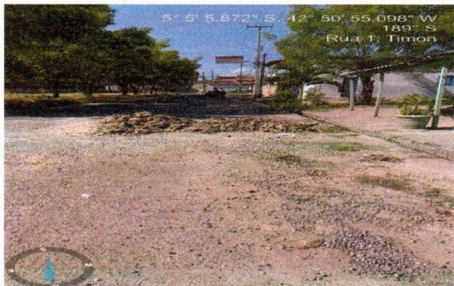
5.3 Pavimentação em paralelepípedo
