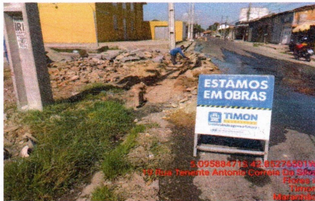
2.2 Escavação manual de vala
