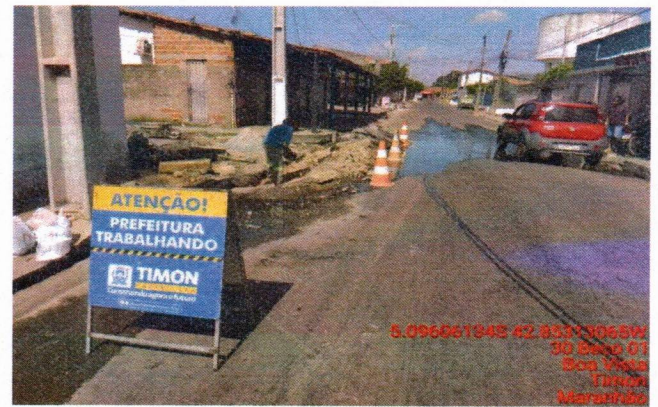
2.2 Escavação manual de vala
