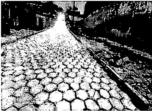
3.2 EXECUÇÃO DE PAVIMENTO EM PISO INTERTRAVADO - RUA 3 - BOA VISTA
