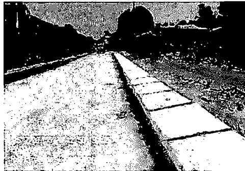
3.10 EXECUÇÃO DE PASSEIO - RUA PROJETADA - CIDADE NOVA 2
