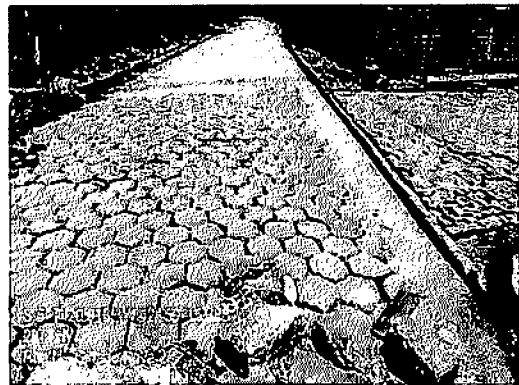
3.2 EXECUÇÃO DE PAVIMENTO EM PISO INTERTRAVADO - RUA N - CIDADE NOVA 2
