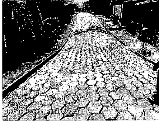
3.2 EXECUÇÃO DE PAVIMENTO EM PISO INTERTRAVADO - RUA 8 - BOA VISTA
