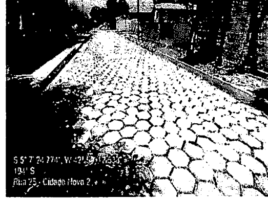
3.2 EXECUÇÃO DE PAVIMENTO EM PISO INTERTRAVADO - RUA 25 - CIDADE NOVA 2
