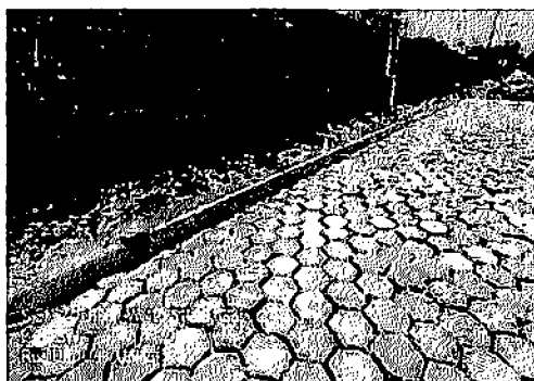
3.2 EXECUÇÃO DE PAVIMENTO EM PISO INTERTRAVADO - RUA 1 - VILA UNIÃO
