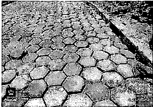
3.8 EXECUÇÃO DE PAVIMENTO EM PISO INTERTRAVADO - RUA 20, SÃO FRANCISCO
