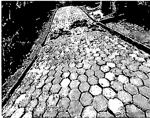
3.2 EXECUÇÃO DE PAVIMENTO EM PISO INTERTRAVADO - RUA 3 - BOA VISTA
