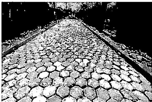
3.2 EXECUÇÃO DE PAVIMENTO EM PISO INTERTRAVADO - RUA 1 - VILA UNIÃO
