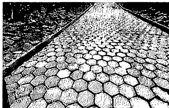
3.2 EXECUÇÃO DE PAVIMENTO EM PISO INTERTRAVADO - RUA 3 - BOA VISTA
