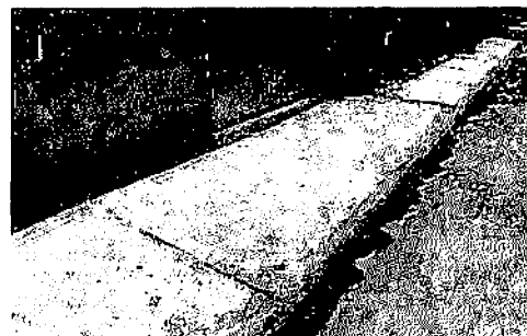
3.10 EXECUÇÃO DE PASSEIO - RUA 30 - CIDADE NOVA 2
