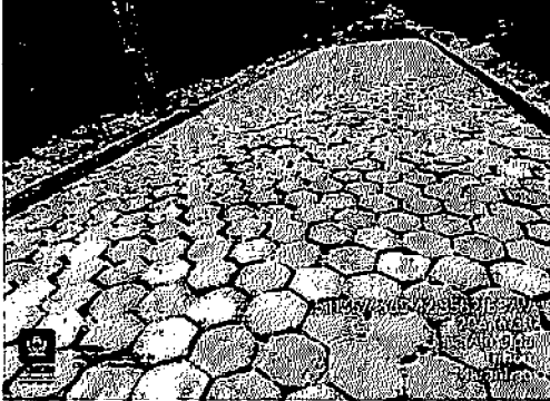
3.8 EXECUÇÃO DE PAVIMENTO EM PISO INTERTRAVADO - RUA 1, JULIA ALMEIDA
