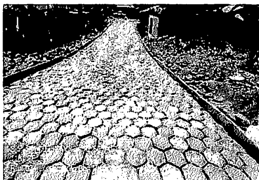
3.2 EXECUÇÃO DE PAVIMENTO EM PISO INTERTRAVADO - RUA 3 - BOA VISTA
