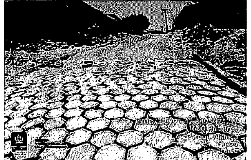
3.8 EXECUÇÃO DE PAVIMENTO EM PISO INTERTRAVADO - RUA 3, PARQUE ALIANÇA
