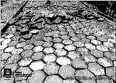
3.8 EXECUÇÃO DE PAVIMENTO EM PISO INTERTRAVADO - RUA 8, BAIRRO SÃO FRANCISCO II
