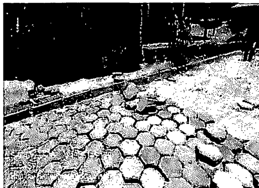
3.2 EXECUÇÃO DE PAVIMENTO EM PISO INTERTRAVADO - RUA 8 - BOA VISTA
