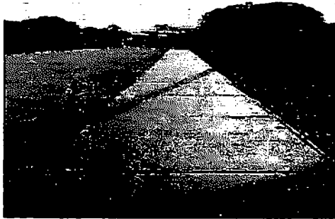
3.10 EXECUÇÃO DE PASSEIO (CALÇADA) - RUA 30, BAIRRO CIDADE NOVA
