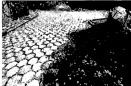
3.2 EXECUÇÃO DE PAVIMENTO EM PISO INTERTRAVADO - RUA 25 - CIDADE NOVA 2
