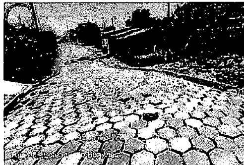
3.2 EXECUÇÃO DE PAVIMENTO EM PISO INTERTRAVADO - RUA 8 - BOA VISTA
