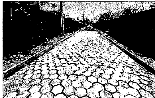
3.2 EXECUÇÃO DE PAVIMENTO EM PISO INTERTRAVADO - RUA 1 - VILA UNIÃO
