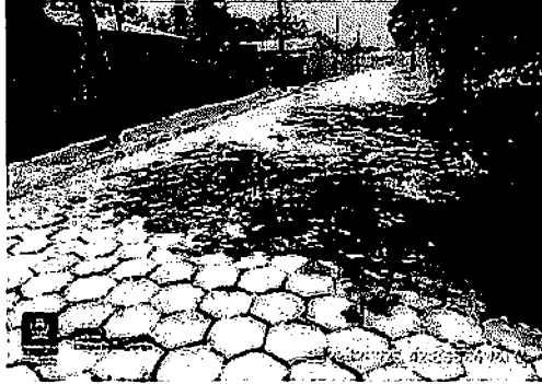
3.8 EXECUÇÃO DE PAVIMENTO EM PISO INTERTRAVADO - RUA DO NORTE, BAIRRO CIDADE NOVA
