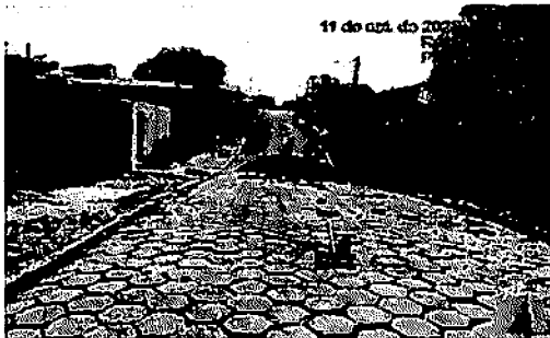
3.2 EXECUÇÃO DE PAVIMENTO EM PISO INTERTRAVADO - RUA 8 - PARQUE ALLIANÇA
