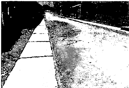
3.10 EXECUÇÃO DE PASSEIO - RUA 30 - CIDADE NOVA 2
