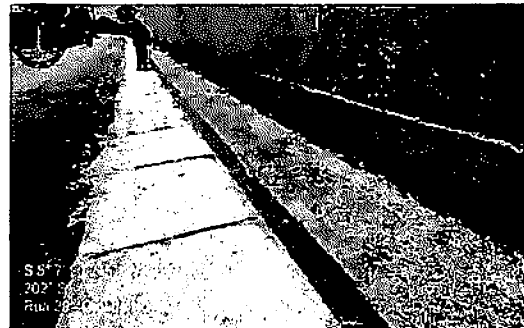
3.10 EXECUÇÃO DE PASSEIO (CALÇADA) - RUA 29 - CIDADE NOVA
