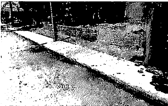
3.10 EXECUÇÃO DE PASSEIO - RUA 30 - CIDADE NOVA 2
