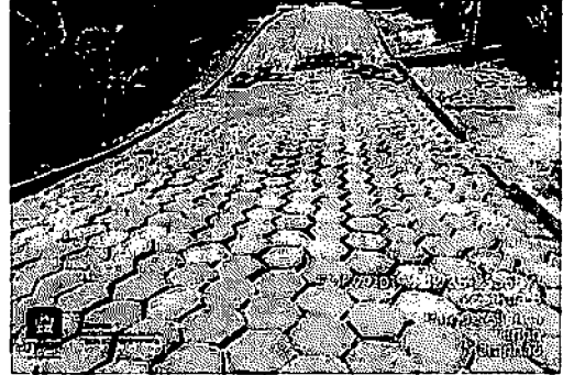
3.8 EXECUÇÃO DE PAVIMENTO EM PISO INTERTRAVADO - RUA 8, PARQUE ALIANÇA
