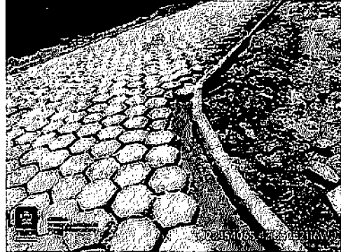
3.8 EXECUÇÃO DE PAVIMENTO EM PISO INTERTRAVADO
