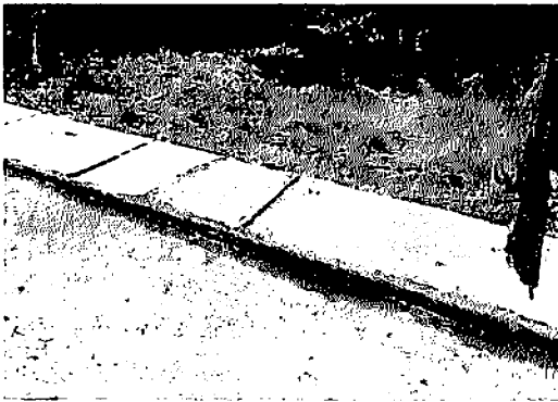
3.10 EXECUÇÃO DE PASSEIO - RUA 30 - CIDADE NOVA 2
