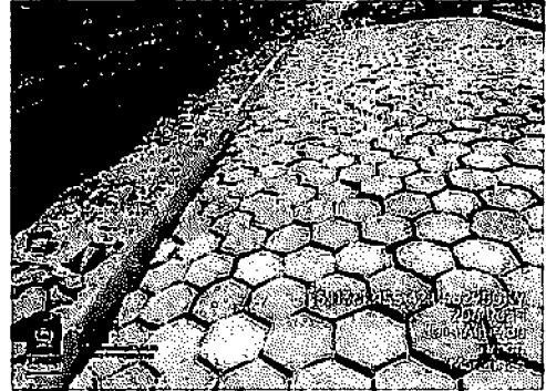
3.8 EXECUÇÃO DE PAVIMENTO EM PISO INTERTRAVADO - RUA 1, JULIA ALMEIDA
