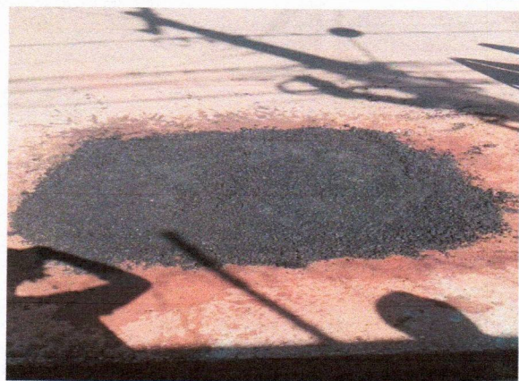
3. PAVIMENTAÇÃO - AVENIDA PRINCIPAL DO MIGUEL ARRAES
