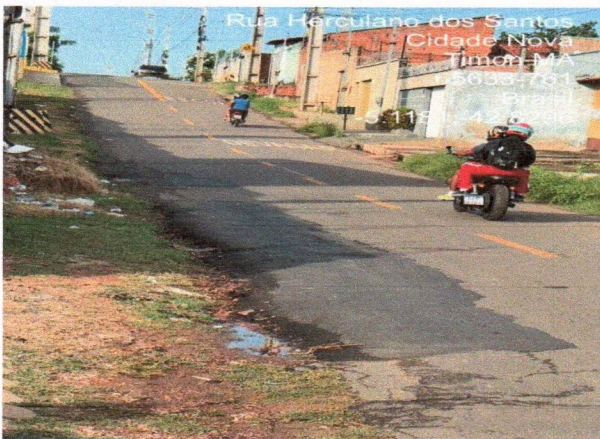
3. PAVIMENTAÇÃO - AVENIDA HERCULANO DOS SANTOS
