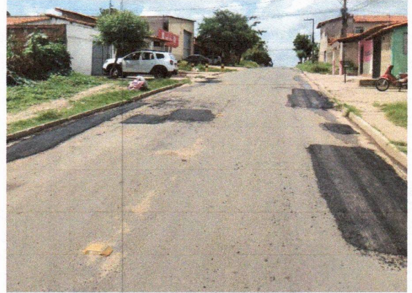
3. PAVIMENTAÇÃO - AV. PERIMETRAL
