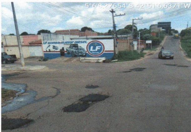
3. PAVIMENTAÇÃO - AV. PERIMETRAL
