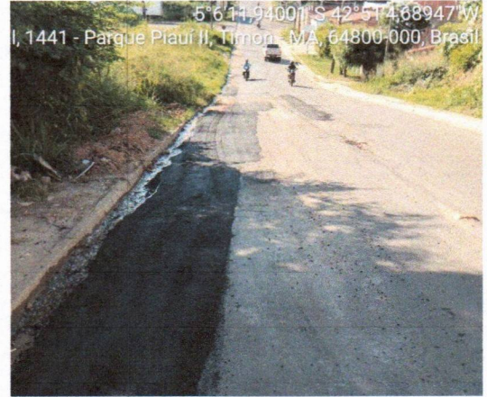
3. PAVIMENTAÇÃO - AV. PERIMETRAL
