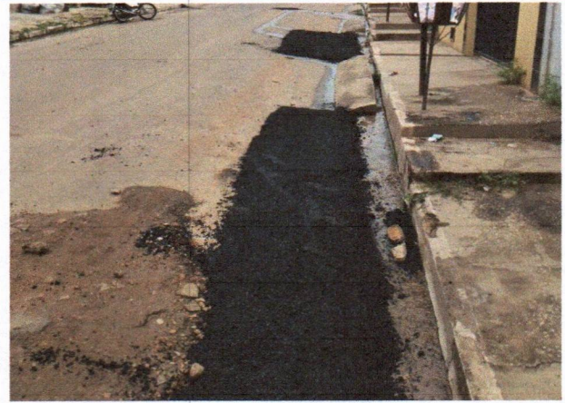
3. PAVIMENTAÇÃO - AV. PERIMETRAL
