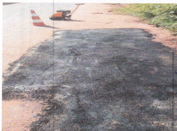
3. PAVIMENTAÇÃO - AVENIDA PRINCIPAL DO MIGUEL ARRAES
