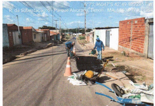
3. PAVIMENTAÇÃO - RUA DA SUBESTAÇÃO
