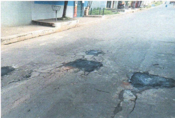
3. PAVIMENTAÇÃO- AV. DO HOSPITAL
