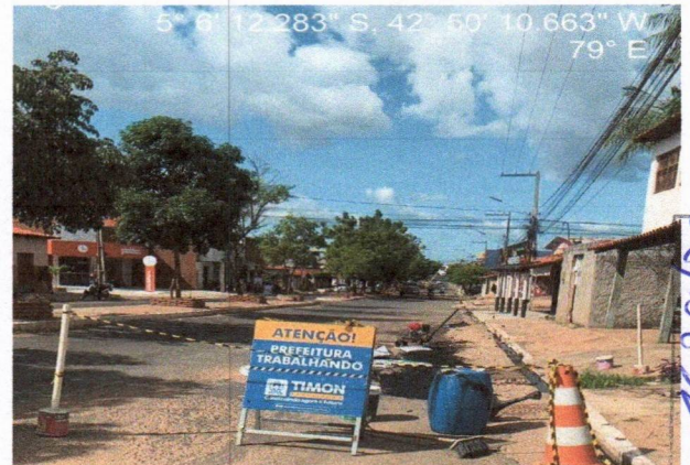
3. PAVIMENTAÇÃO - AV. DO HOSPITAL
