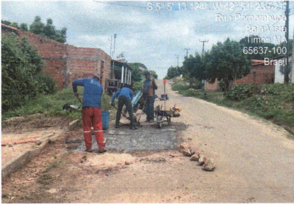
3. PAVIMENTAÇÃO - RUA PERNAMBUCO
