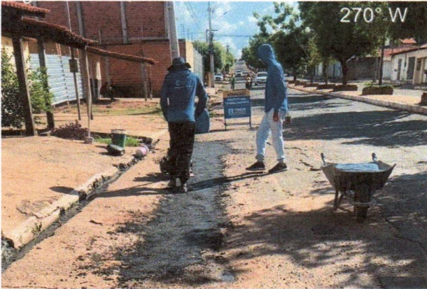
3. PAVIMENTAÇÃO - AV. DO HOSPITAL
