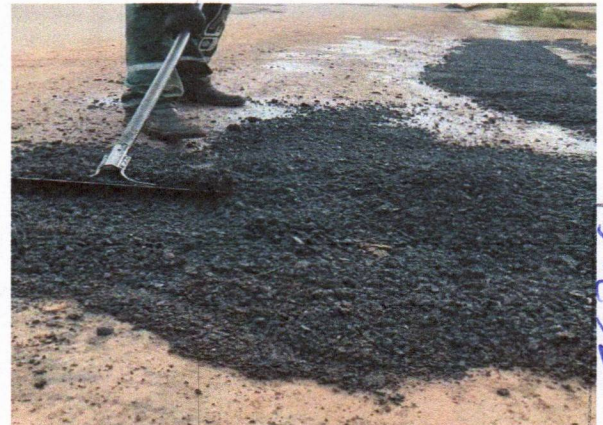
3. PAVIMENTAÇÃO - AV. BOA ESPERANÇA
