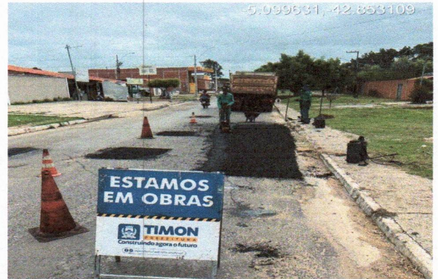
3. PAVIMENTAÇÃO - AV. PERIMETRAL
