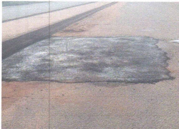
3. PAVIMENTAÇÃO - AVENIDA PRINCIPAL DO MIGUEL ARRAES
