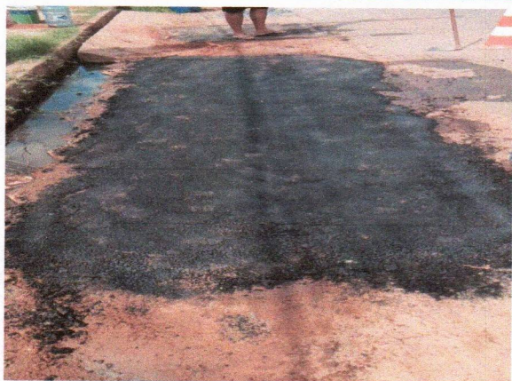
3. PAVIMENTAÇÃO - AVENIDA PRINCIPAL DO MIGUEL ARRAES
