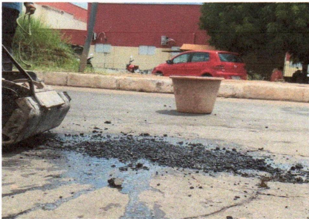
3. PAVIMENTAÇÃO - AV. DO HOSPITAL
