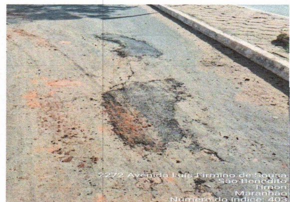
3. PAVIMENTAÇÃO-AVENIDA LUIS FIRMINO DE SOUSA
