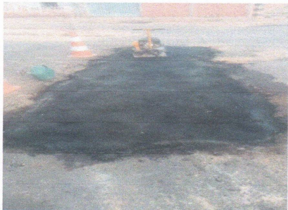
3. PAVIMENTAÇÃO - AVENIDA PRINCIPAL DO MIGUEL ARRAES
