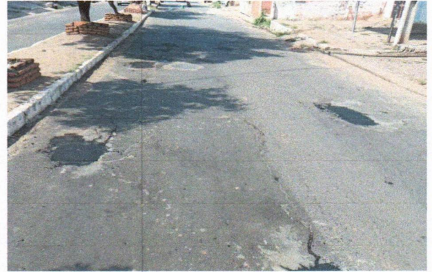
3. PAVIMENTAÇÃO- AV. DO HOSPITAL
