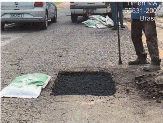
3. PAVIMENTAÇÃO - AV. FRANCISCO CARLOS JANSEN
