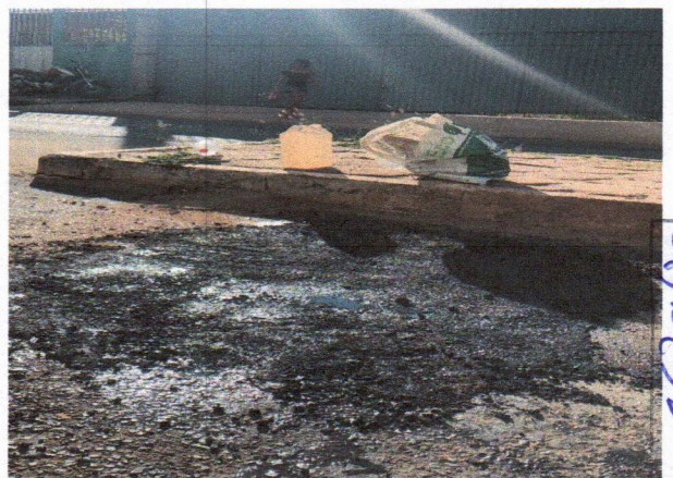
3. PAVIMENTAÇÃO - AVENIDA DO HOSPITAL
