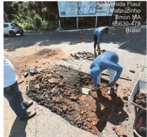
3. PAVIMENTAÇÃO - AVENIDA PIAUÍ
