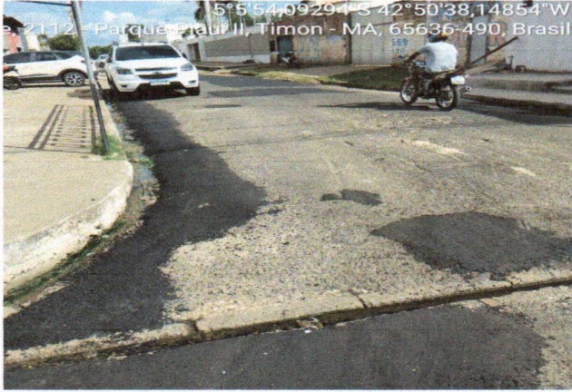
3. PAVIMENTAÇÃO - RUA 17, PARQUE PIAUÍ
