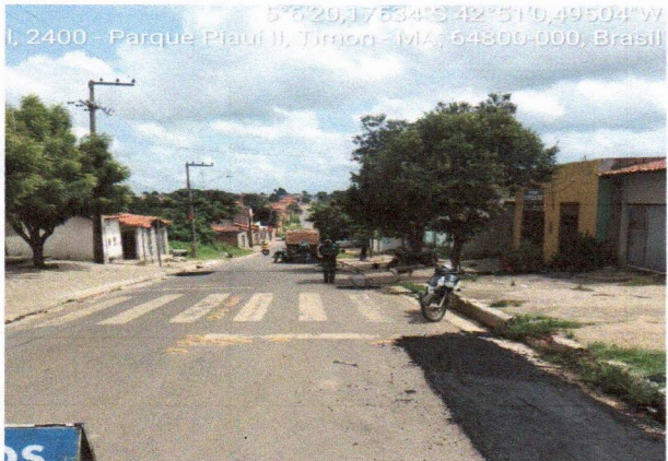
3. PAVIMENTAÇÃO - AV. PERIMETRAL
