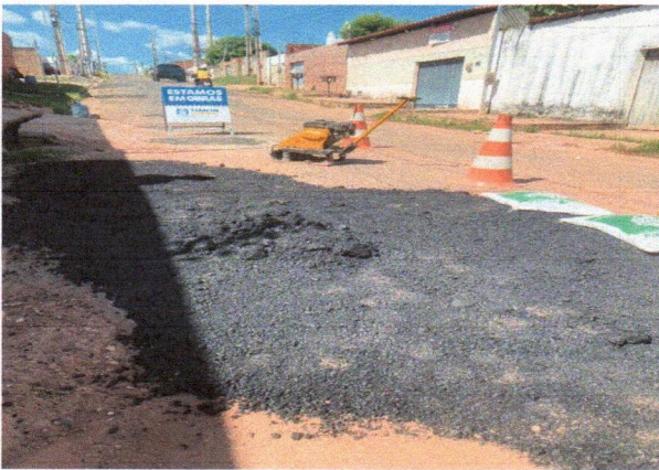
3. PAVIMENTAÇÃO - AVENIDA HERCULANO DOS SANTOS
