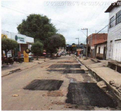
3. PAVIMENTAÇÃO - AV. PERIMETRAL
