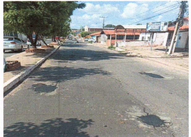
3. PAVIMENTAÇÃO - AV. DO HOSPITAL
