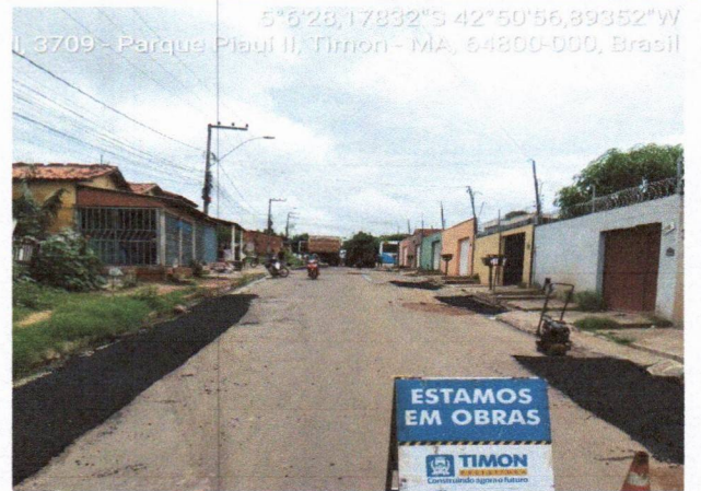
3. PAVIMENTAÇÃO - AV. PERIMETRAL
