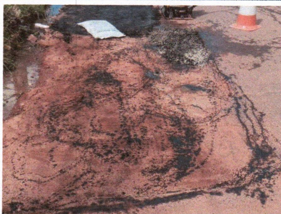
3. PAVIMENTAÇÃO - AVENIDA PRINCIPAL DO MIGUEL ARRAES
