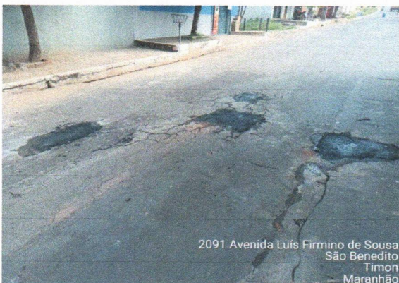
3. PAVIMENTAÇÃO- AVENIDA LUIS FIRMINO DE SOUSA
