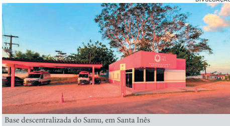
Base descentralizada do Samu, em Santa Inês
