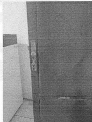
Figura 12 - Maçaneta quebrada
