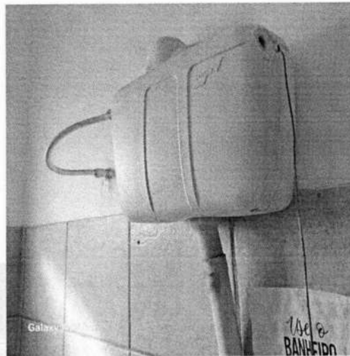
Figura 33 - Descarga quebrada
