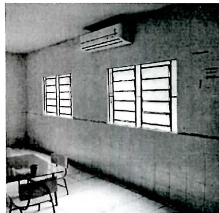
Foto 8: SALA DE AULA
